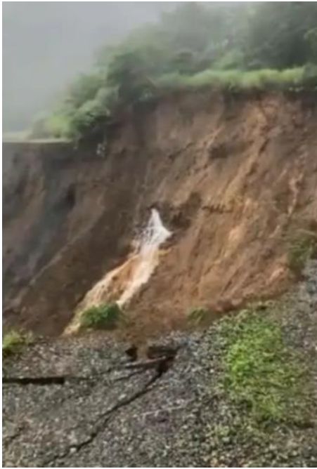
図3 崩壊斜面からパイプ状に 吹き出す地下水※5)
