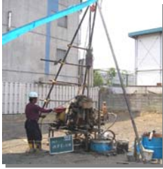
ボーリング調査
