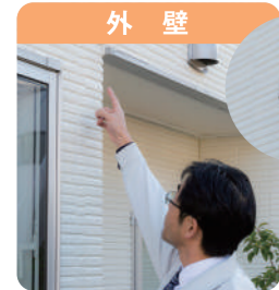
外壁 外壁のひび割れ、欠損、はがれ、サッシの周囲の隙間、開閉不良はないか
