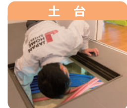
土台 土台のひび割れ、劣化はないか
