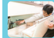
給排水管路検査
