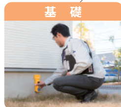
基礎 基礎のひび割れ、欠損、劣化はないか
