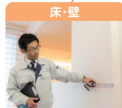
床・壁 床・壁の傾斜はないか
