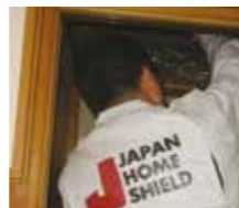
■ 小屋裏の劣化状況の確認
