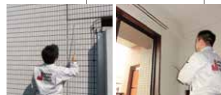
■ 外壁・内壁の劣化状況の確認
