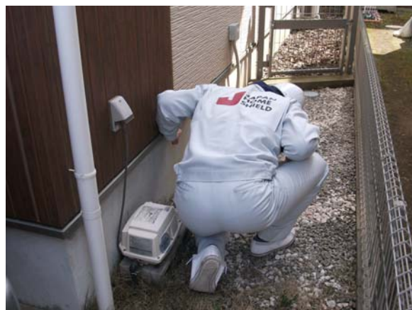
&lt;基礎の点検&gt;
