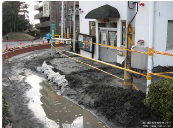
東日本大震災で発生した液状化（千葉県浦安市）
